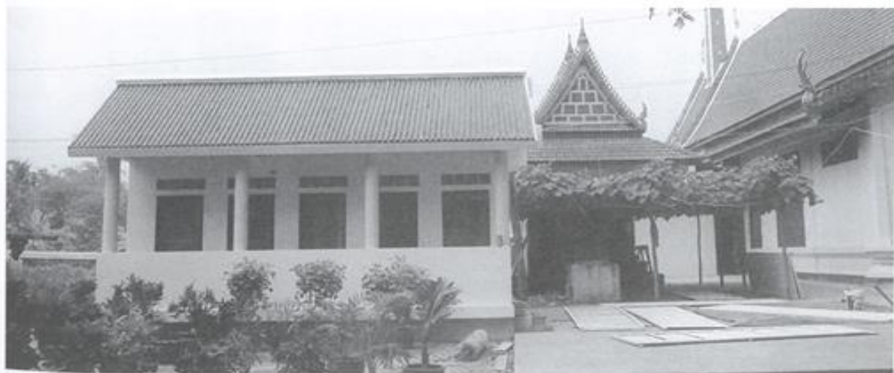
ห้องน้ำสร้างใหม่ หลังคาใช้วัสดุนิรทำ
